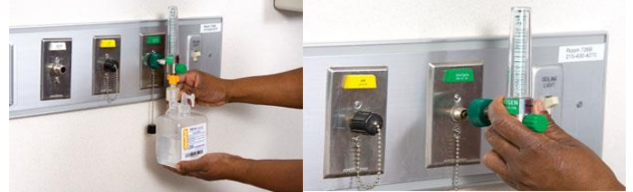
سیلندر اکسیژن و مانومتر را چک و بررسی کنید (از نظر پر بودن کپسول و عدم نشتی و وجود آب مقطر در سیستم مرطوب کننده)
